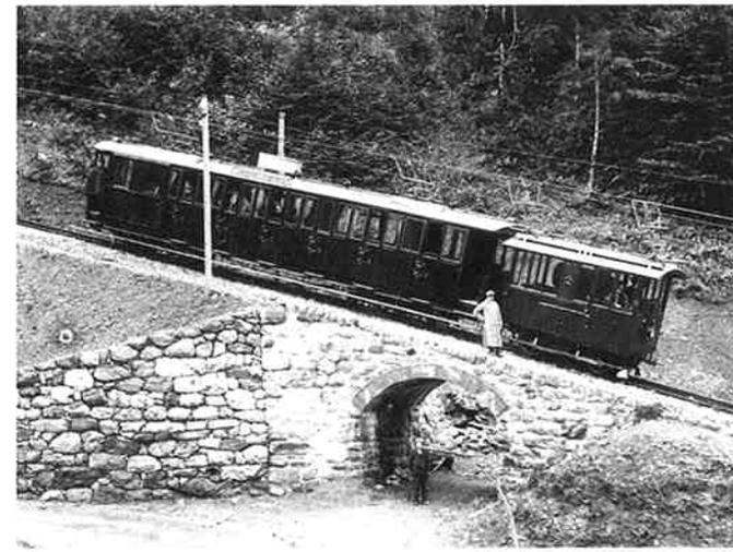
*Zug der mit Drehstrom (dreiphasigem Wechselstrom) betriebenen Stansstad-Engelberg-Bahn über einem Wegdurchlass auf der Zahnstangenstrecke zwischen Obermatt und Ghärst, um 1899.*
